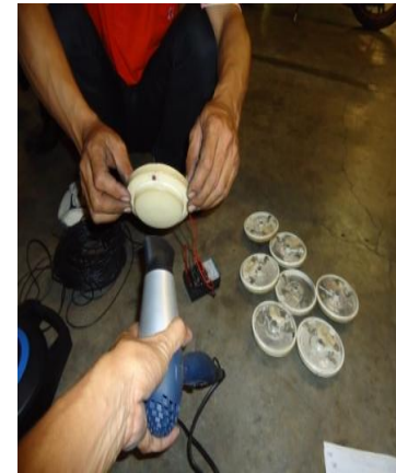
Photo pengecekan kabel point dan detektor di zona 20 Parkir A.
