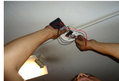
Photo kegiatan pengecekan kabel & detektor di zona 20 Lantai Parkir A
