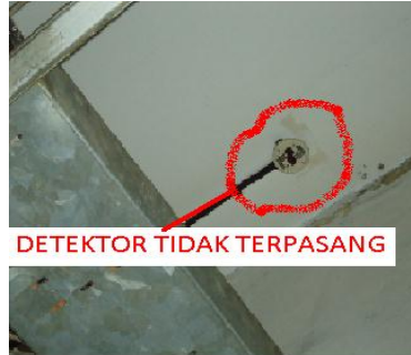
Photo kondisi detektor di ruang panel listrik basement
