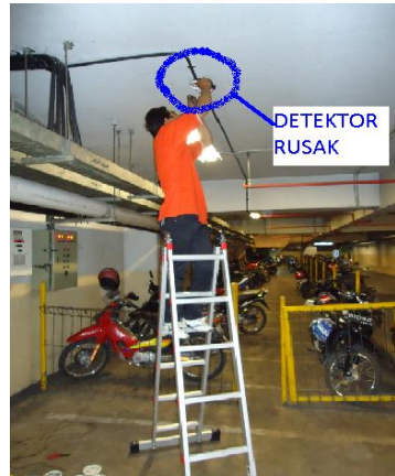
Photo pengecekan kabel point dan detektor di zona 20 Parkir A.
